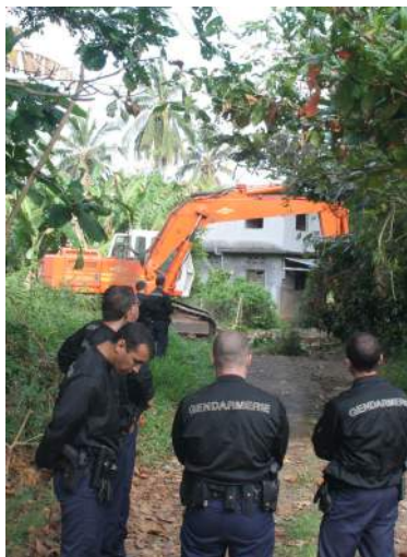
Les forces de l'ordre avaient été mobilisées pour cette opération de destruction.
